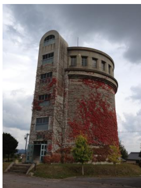
昔は浄水場でした。今は排水塔として現役です。
